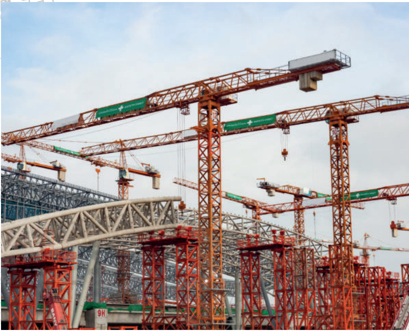
شكل 1.8: إنشاء قطار الأنفاق (المترو) في الرياض
